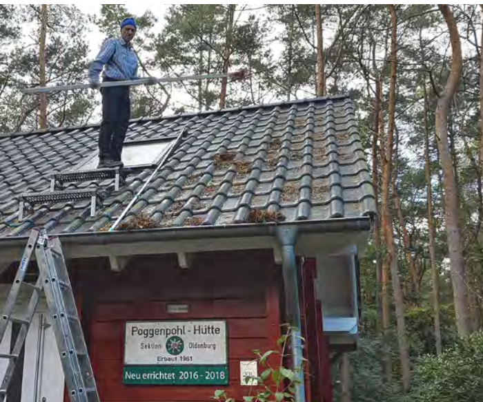
... Andreas befreit dann das Dach damit von zentnerweise Kiefernadeln
