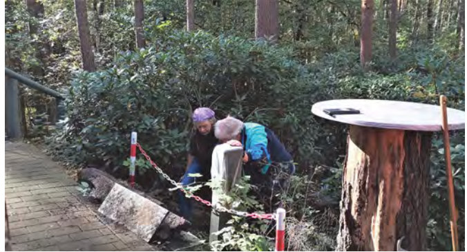
Rita und Heino reißen die defekten Treppenbohlen weg
